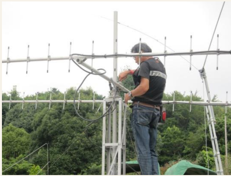
富士見台でのアンテナ設置
